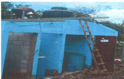
Foto 3: reparación del techo area baños
