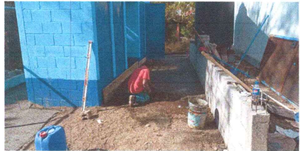
Foto 2: aplicación de cemento
