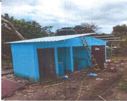
Foto1: instalación de techo en area de pila, tinaco y baños
