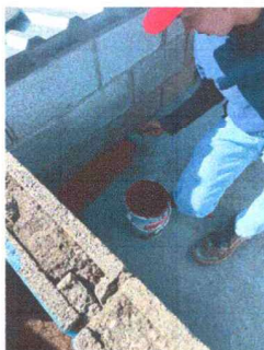
Foto 5: aplicación de pintura en area de tinaco para evitar filtraciones
