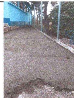
Foto 6: aplicación de cemento en losa
