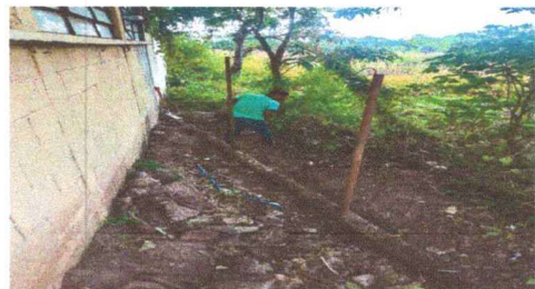
Foto 4: trabajo en malla
