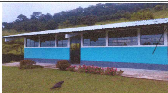
Foto 5: Lámina y estructura de techo reparada
