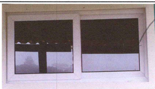
Foto 6: Ventana y puerta reparada
