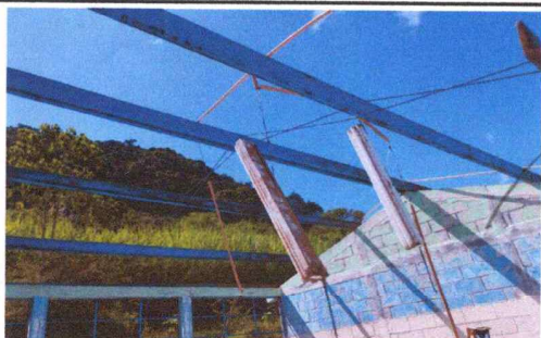
Foto 1: Remoción de techo.
