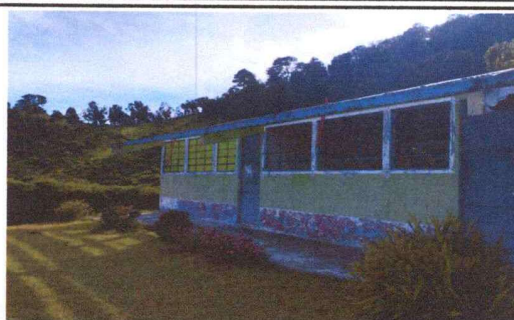
Foto 2: Limpieza de paredes.
