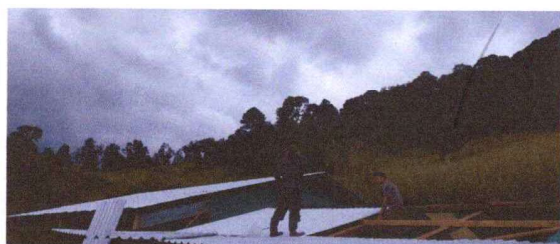
Foto 3: Colocación de lámina
