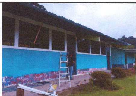
Foto 5: Proceso de pintura en paredes
