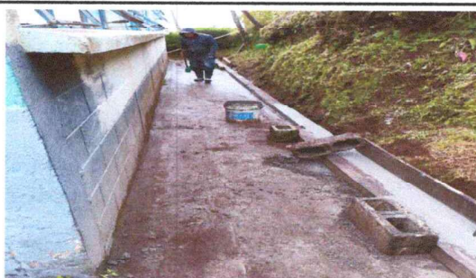
Foto 4: Fundición de losa
