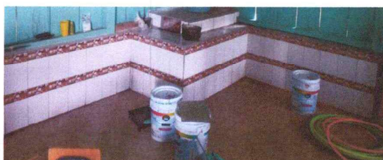
Foto 6: Reparación de plancha y estufa
