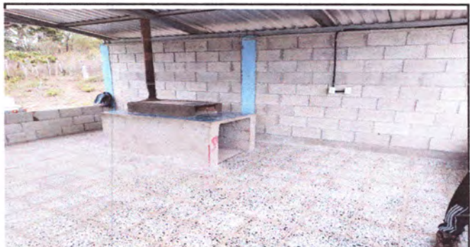
Foto4: Reparación de muros de cocina
