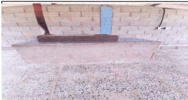
Foto3: Reparación de piso y sistema electrico
