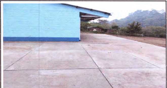
FOTO 2: Reparación de losa de patio.
