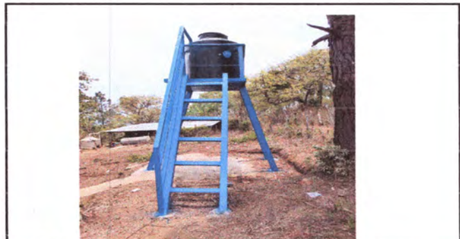
Foto: 6 Mantenimiento de deposito de agua.
