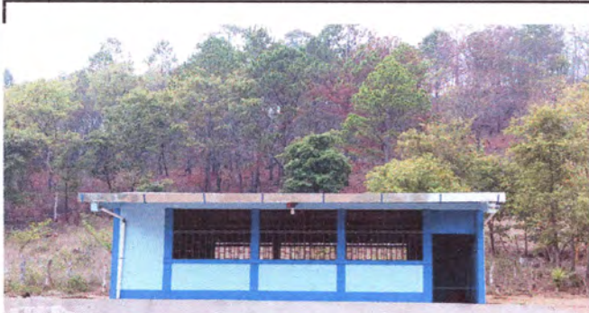
Foto1: Reparació de Pintura interior y exterior, sistema electrico, cuneta de concreto.
