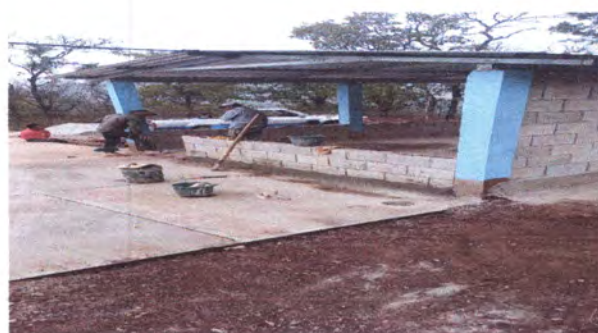
Foto4: Reparación de muros de cocina
