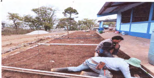
FOTO 2: Reparación de losa de patio.
