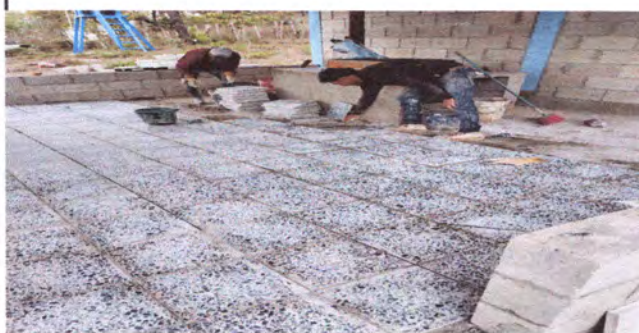
Foto3: Reparación de piso y sistema eléctrico
