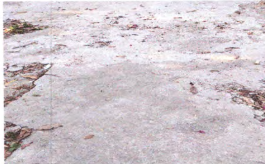
FOTO 2: Reparación de losa de patio.
