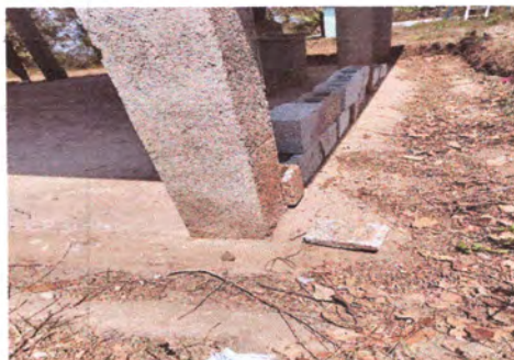
Foto4: Reparación de muros de cocina
