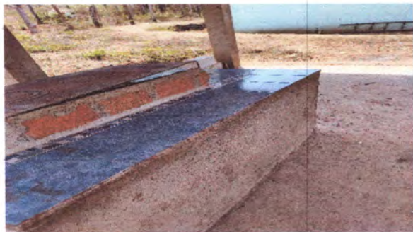
Foto3: Reparación de piso y sistema eléctrico
