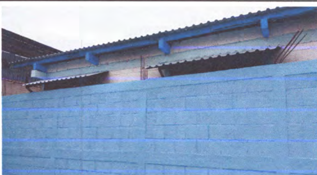
Foto 4: Pintura en paredes interior y exterior.
