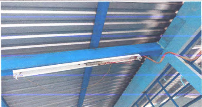
Foto1: Cambio de sistema eléctrico.
