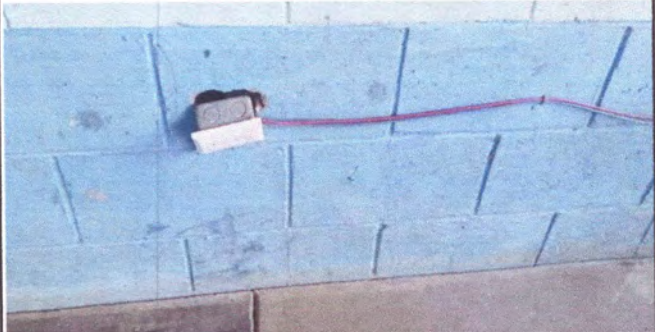
Reparación del Sistema Electrico en Computación
