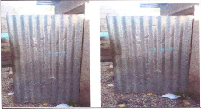
Cambio de Puertas de Baños
