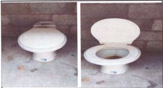
Sustitucion de Sanitarios
