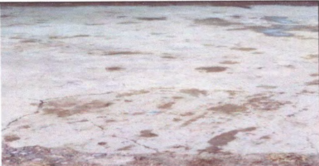
Reparación de Torta
