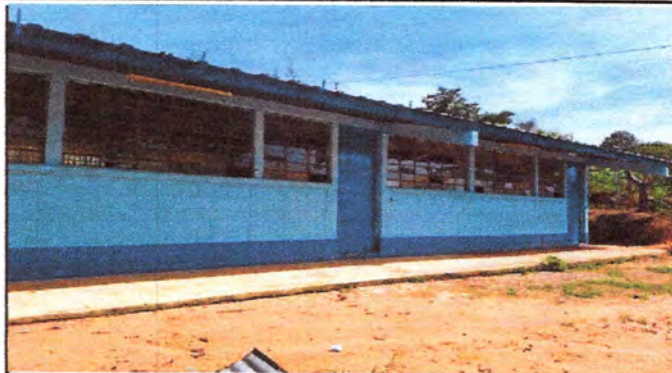
FOTO 2: Mantenimiento de puertas
