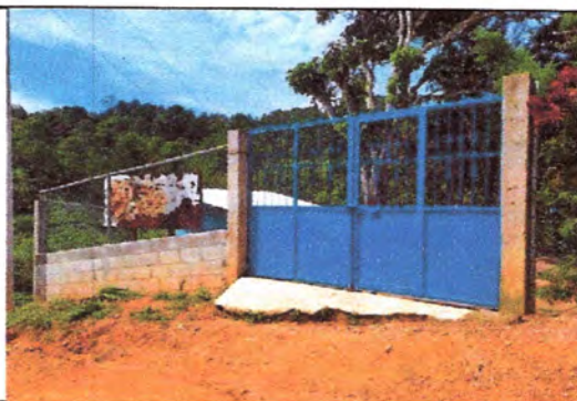
Foto: 6 mantenimiento a portones
