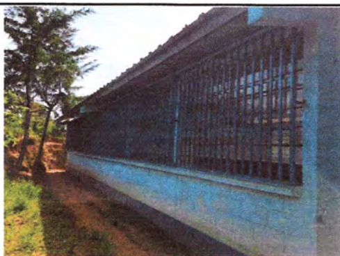
Foto3: Mantenimiento de balcones
