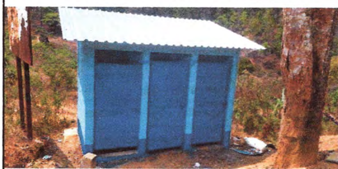
Foto1: cubierta de lamina de sanitario
