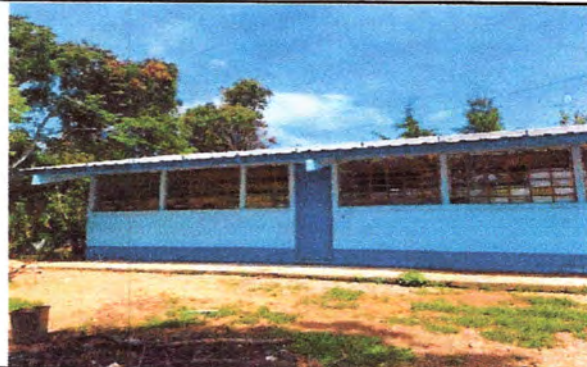
Foto4: Pintura en muros interior y exterior
