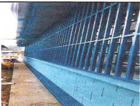
Foto3: Mantenimiento de balcones
