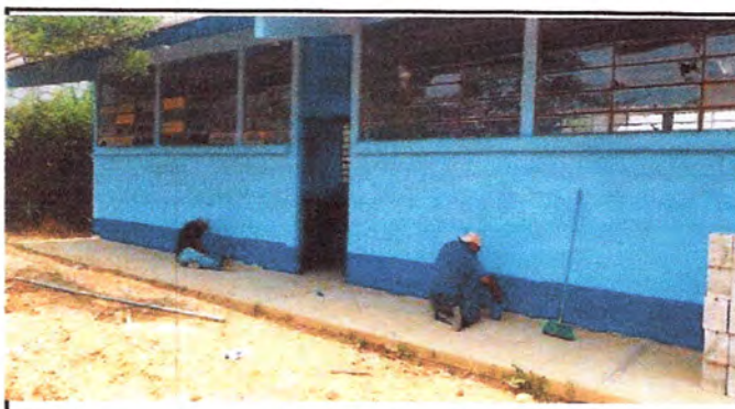
Foto4: Pintura en muros interior y exterior
