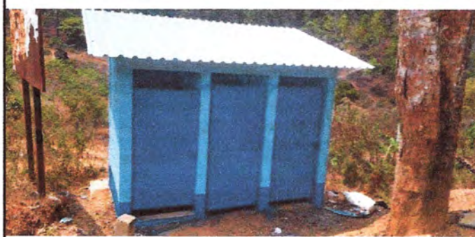
Foto1: cubierta de lamina de sanitario
