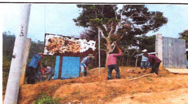
Foto: 6 mantenimiento a portones
