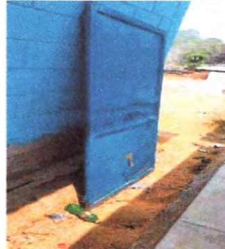
FOTO 2: Mantenimiento de puertas
