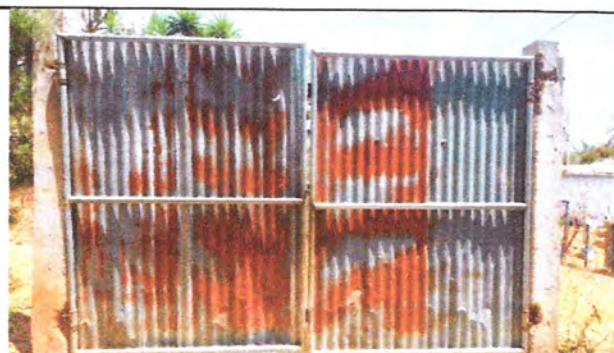
Foto: 6 mantenimiento a portones
