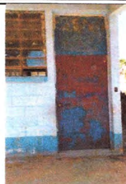
FOTO 2: Mantenimiento de puertas
