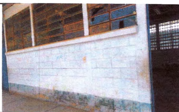
Foto4: Pintura en muros interior y exterior
