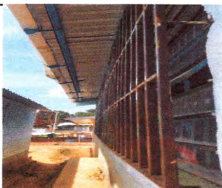
Foto3: Mantenimiento de balcones
