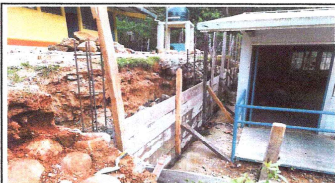
Foto 3: Construcción de muro de contención.
