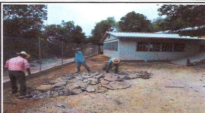
Foto 2: Sustitución de losa de patio.
