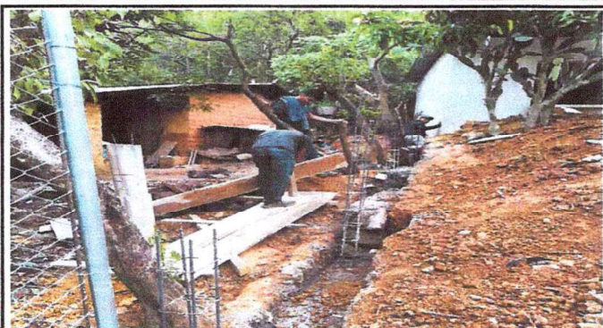
Foto 1: Cerco o muro perimetral en construcción.
