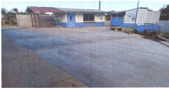
Foto 3: Losa de patio terminado
