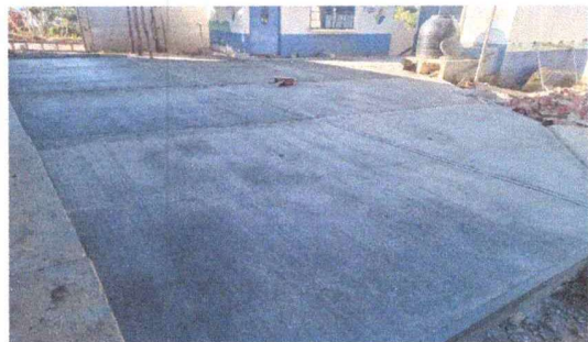
Foto 4: Losa en el patio con un 100% terminado
