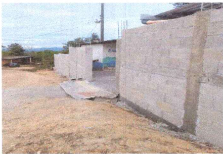
Foto 1: Muro Perimetral finalizado
