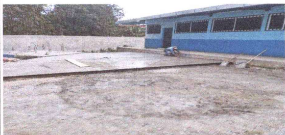
Foto 3: Losa en proceso
