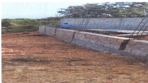
Foto 1: Muro Perimetral en proceso
