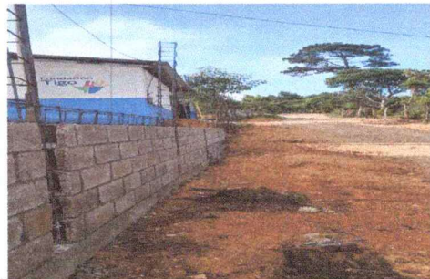
Foto 2: Muro perimetral con un avance de 60%
