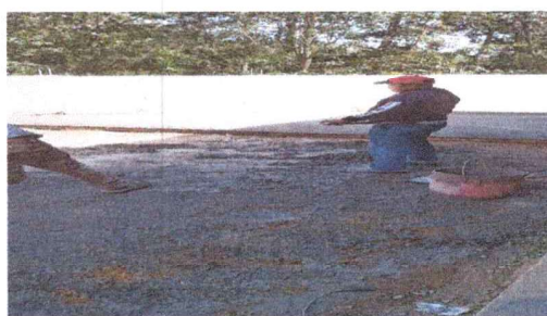
Foto 4: Losa en el patio con 50% de avance
