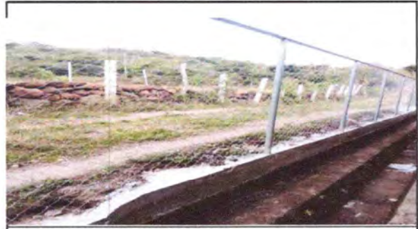
Foto 8: CERCO O MURO PERIMETRAL
