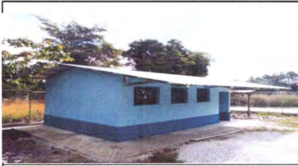
Foto7: PINTURA EN MUROS INTERIOR Y EXTERIOR
