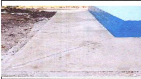
Foto 9: LOSA DE PATIO
