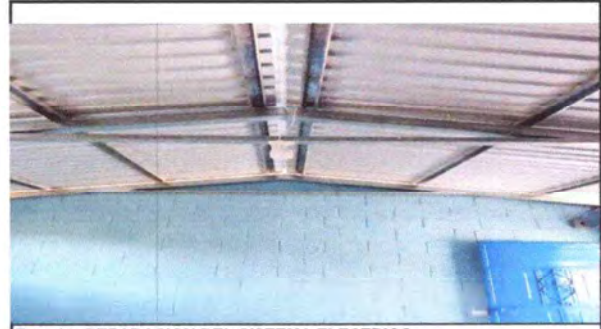
Foto 10: REPARACION DEL SISTEMA ELECTRICO
