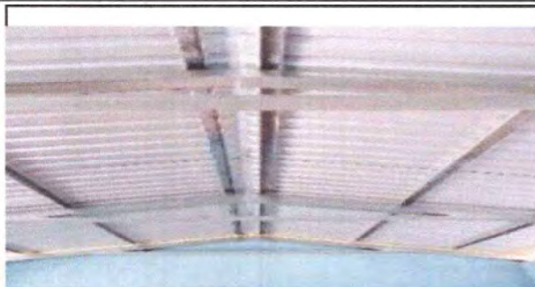
Foto 1: CUBIERTA DE LAMINA
