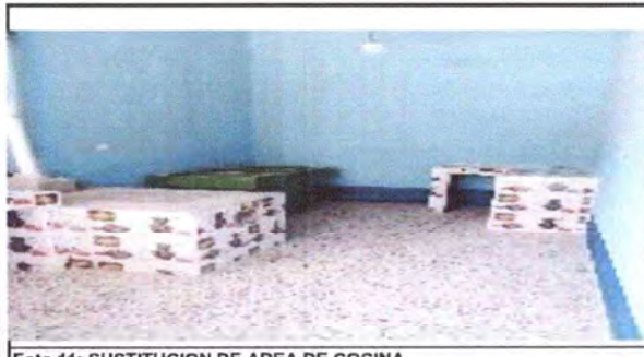
Foto 11: SUSTITUCION DE AREA DE COCINA
