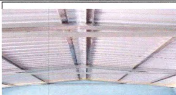
Foto 2: ESTRUCTURA DE TECHO
