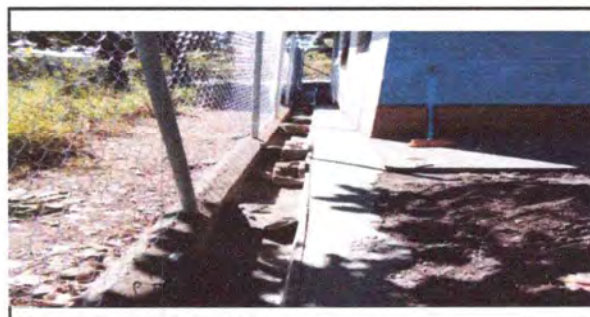
Foto 6: CUNETA DE CONCRETO
