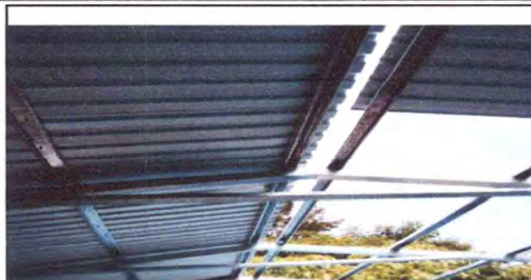
Foto 2: ESTRUCTURA DE TECHO
