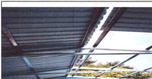
Foto 1: CUBIERTA DE LAMINA
