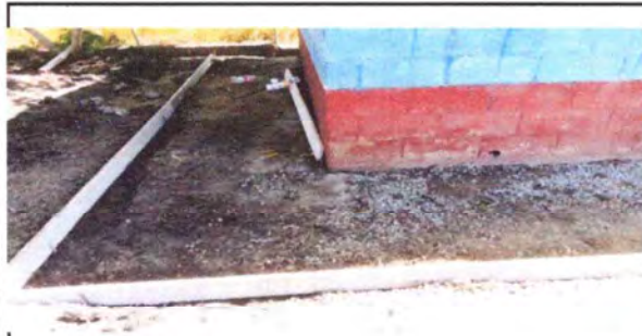
Foto 9: LOSA DE PATIO
