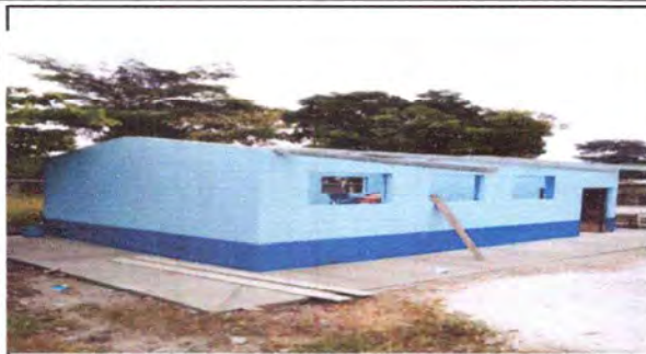
Foto 7: PINTURA EN MUROS INTERIOR Y EXTERIOR
