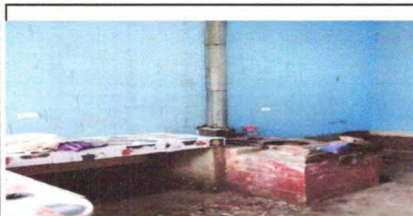
Foto 11: SUSTITUCION DE AREA DE COCINA
