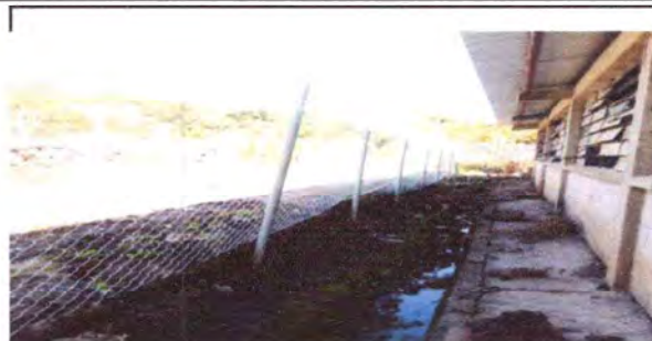
Foto 8: CERCO O MURO PERIMETRAL
