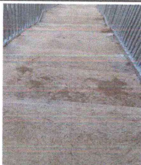
Foto 5: SUSTITUCIÓN LOSA DE PATIO INCLUY BASE, FUNDICION Y ACABADO
