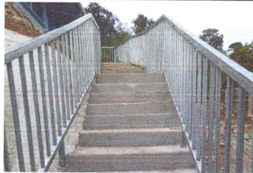
Foto 4: REPARACION Y MANTENIMIENTO A BARANDAS
