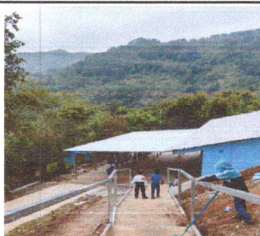
Foto 4: REPARACION Y MANTENIMIENTO A BARANDAS
