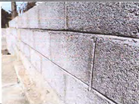
Foto 5: CERCO MURO PERIMETRAL, REPARADO
