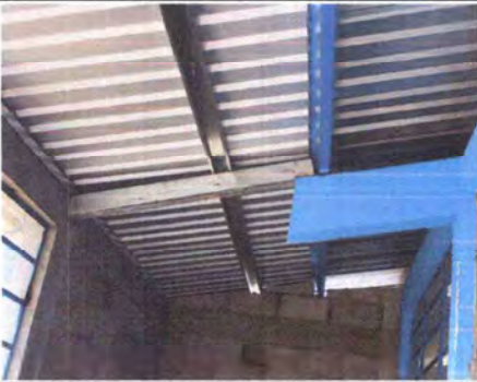
Foto1: CUBIERTA DE LAMINA Y ESTRUCTURA DE TECHO, REPARADO
