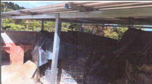
Foto 3: CANALES Y BAJADAS DE AGUA PLUVIAL, REPARADO
