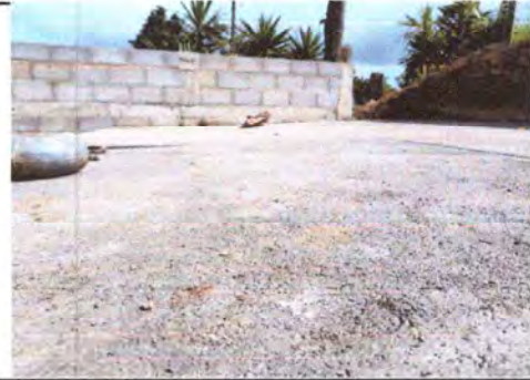
Foto 6: LOSA DE PATIO, REPARADO
