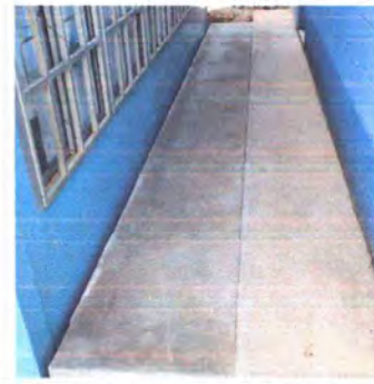
Foto 4: CUNETETA DE CONCRETO, REPARADO
