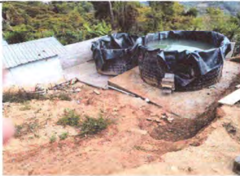
Foto1: REPARACIÓN Y MANTENIMIENTO DE CISTERNAS
