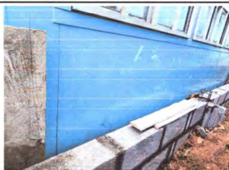
Foto 4: CUNETA DE CONCRETO
