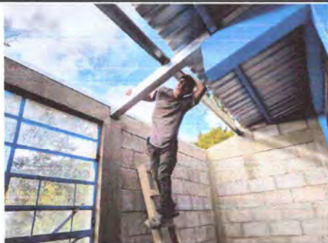
Foto 1: CUBIERTA DE LAMINA Y ESTRUCTURA DE TECHO EN MAL ESTADO.
