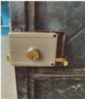
Foto 5: Reparación de Chapas de puertas
