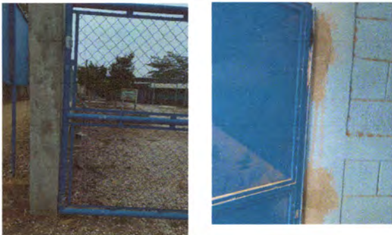
Foto 6: Reparacion de Portón y Puertas
