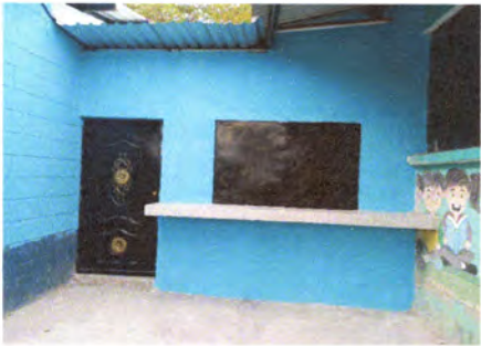
Foto1: Puerta y ventana de cocina
