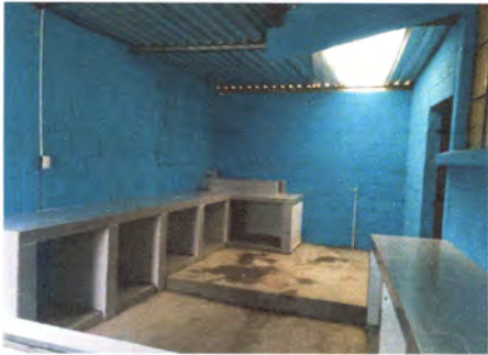
Foto 2: interior de cocina y techado
