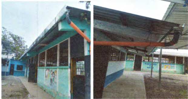
Foto 4: Canales y bajadas de aguas pluviales
