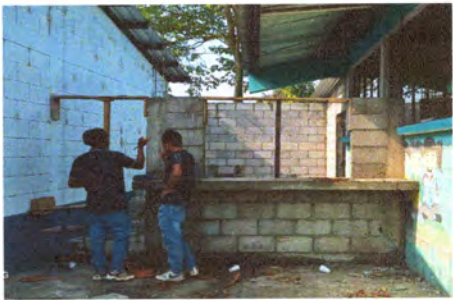
Foto 2: Perimetro de cocina
