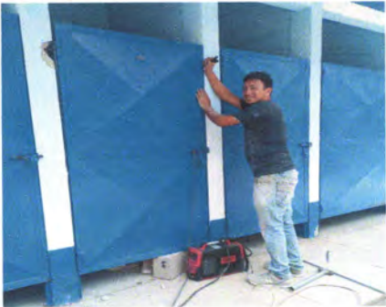
Foto 5: Reparación de Puertas y Portones
