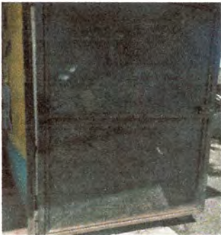
Foto: Reparación de Chapas y Puertas
