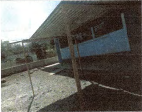
FOTO 2: Suministro e Instalación de lámina y Parales
