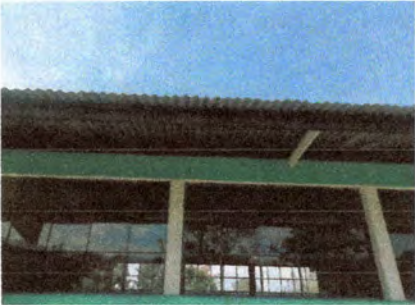
Foto3: Canales y bajadas de agua pluvial
