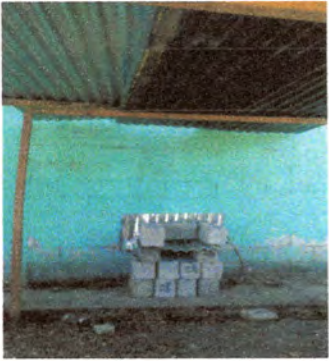
Foto1: Reparación del área de cocina y techo
