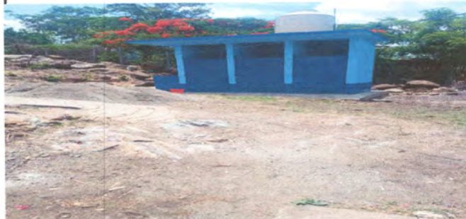
Foto 4: pintado y reparacion de puertas exterior
