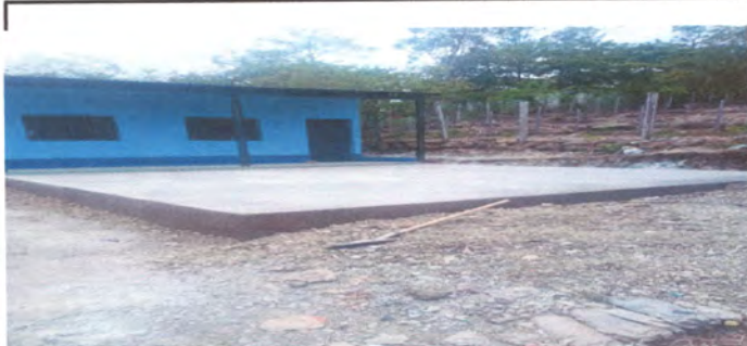
Foto 5: fundicion y demolicio de contrapiso de patio exterior terminado
