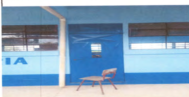
Foto 6: pintado y reparacion de puertas exterior
