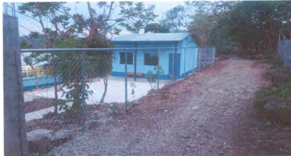
Foto 2: reparacion de maya y entubado de la misma
