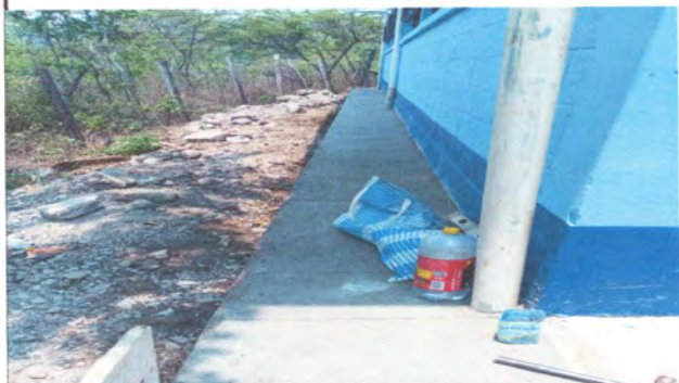
Foto 1: finalizado trabajo de banquetas exterior
