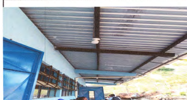
Foto 6: instalacion de alumbrado electrico
