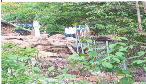
Foto 2: reparacion de malla y colocacion de tubería
