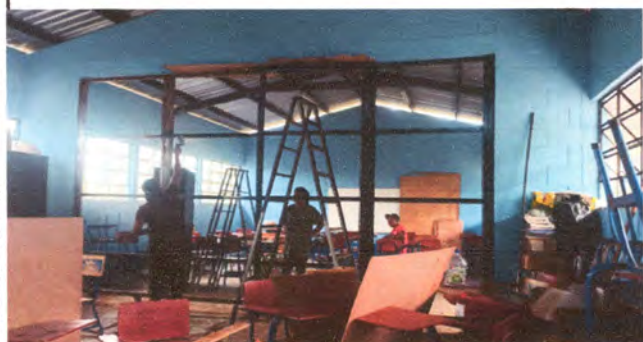
Foto1: reparacion de puerta interna
