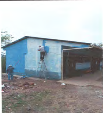
Foto 3: pintado de paredes de exteriores
