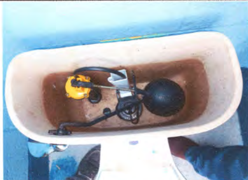
Foto 5: instalacion y reparacion de baños
