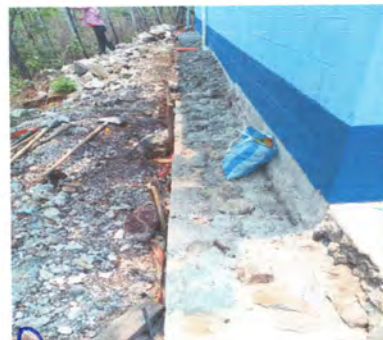
Foto 6: banquetas en mal estado
