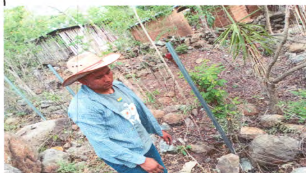
Foto 4: reparacion y mantenimiento de malla
