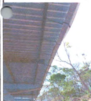
Foto: 5 reparacion de canales y banqueta
