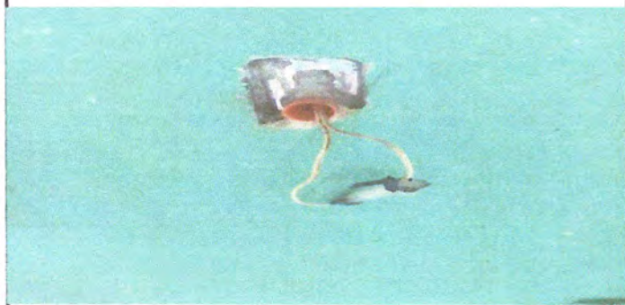
Foto1: reparación de energía eléctrica
