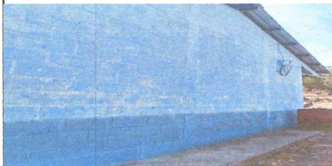
FOTO 2: pintura en muros interior y exterior
