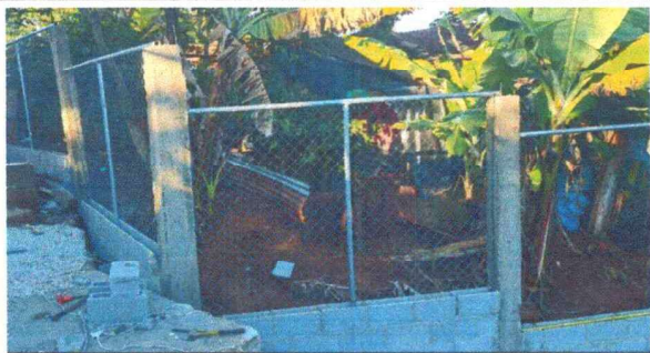
Foto 5: Cerco en mal estado y sustitución por malla.
