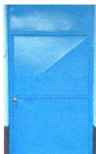
Foto 6: Mantenimiento a puertas de aulas y baños.
