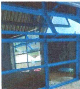
Foto 3: Ventanas requieren mantenimiento y cambio de vidrios quebrados en toda la escuela.
