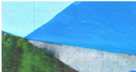
Foto 4: Pintura de muros internos y externos.
