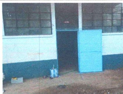
Foto 6: Mantenimiento a puertas de aulas y baños.
