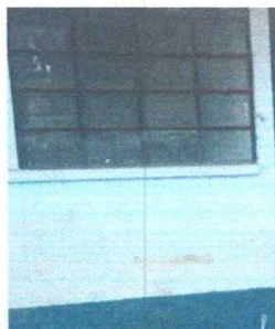
Foto 4: Pintura de muros internos y externos.
