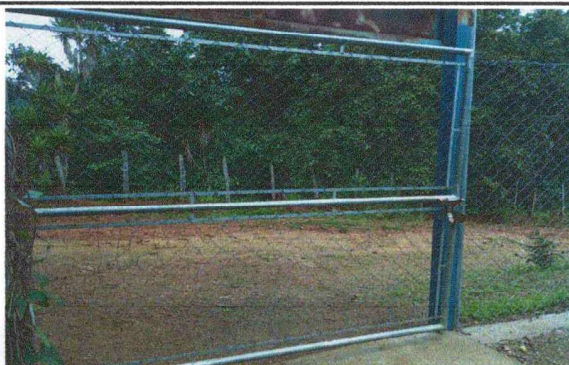
Foto 3: se observa el portón reparado
