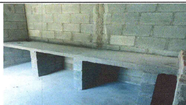
Foto 6: se observa el interior de la cocina terminada
