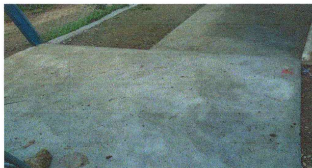
Foto 4: se observa la losa de patio terminada
