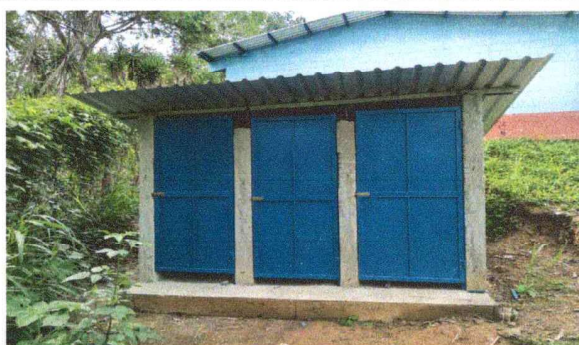
Foto 5: se observa las letrinas terminadas
