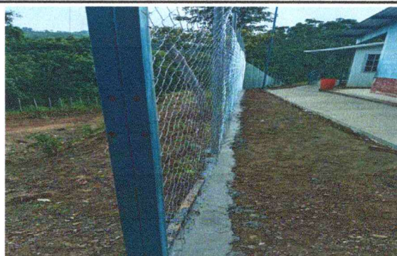
Foto 2: se observa muro perimetral terminado
