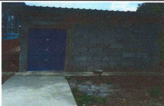
Foto 1: se observa la cocina terminada, predes, techo y puerta
