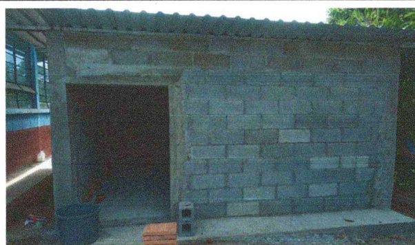
Foto 2: COLOCACION TECHO COCINA
