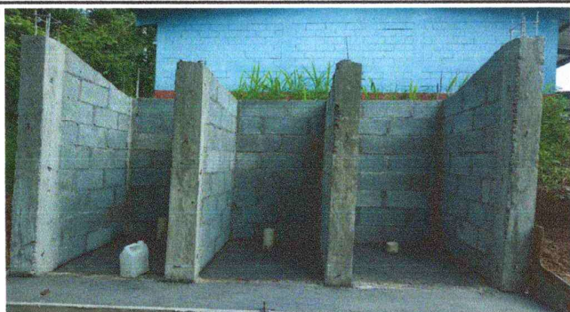
Foto 5: TERMINACION PAREDES BAÑOS
