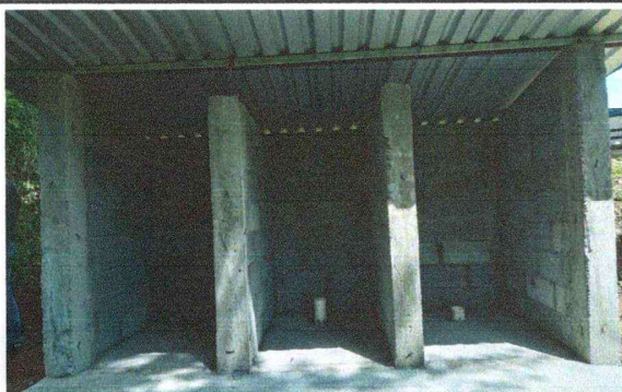
Foto 3: COLOCACION TECHO BAÑOS
