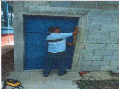
Foto1: COLOCACION PUERTA COCINA
