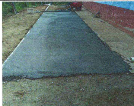
Foto 4: FUNDICION LOSA DE PATIO
