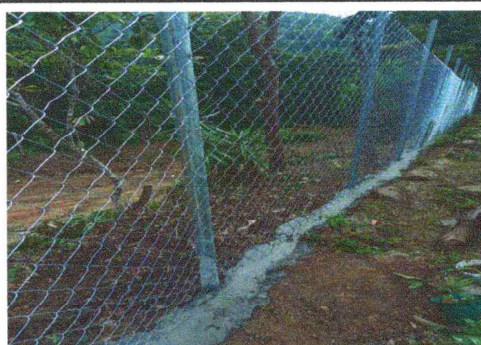
Foto 6: COLOCACION MALLA PERIMETRAL
