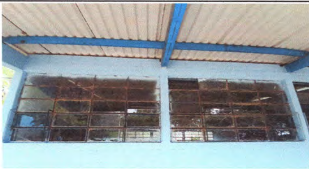
Foto 5: Reparacion de de vidrios de ventanales terminado
