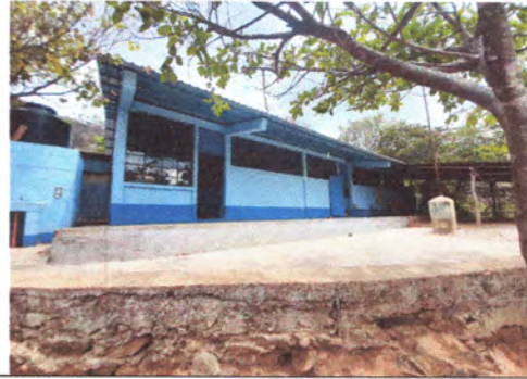
Foto 2: Pintura y losa de pario terminado
