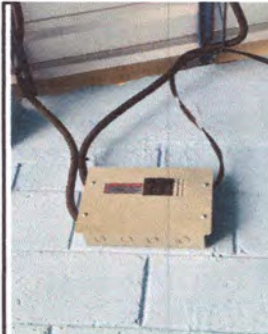
Foto 6: Sistema eléctrico terminado
