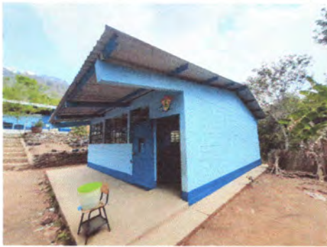
Foto 3: Pintura de muro exterior
