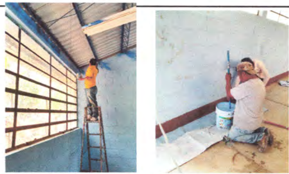
Foto 6: Pintura de muros interiores y exteriores
