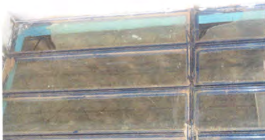
Foto: 5 Reparacion de vidrios de ventanas
