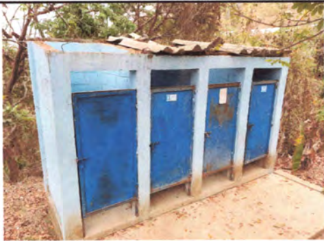
Foto3: reparacion de techo de baños y puerta
