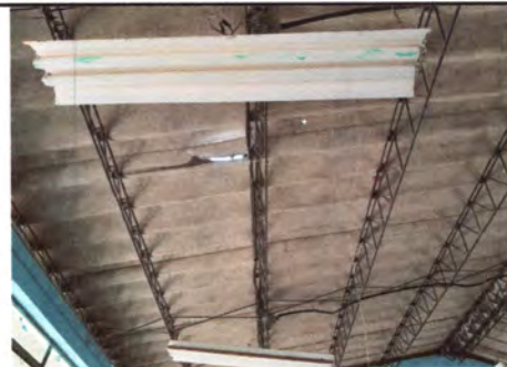
Foto: 6 Reparacion de sistema electrico
