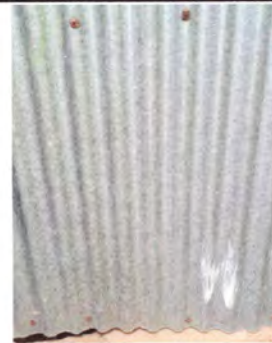
Foto4: Sustitucion de puerta
