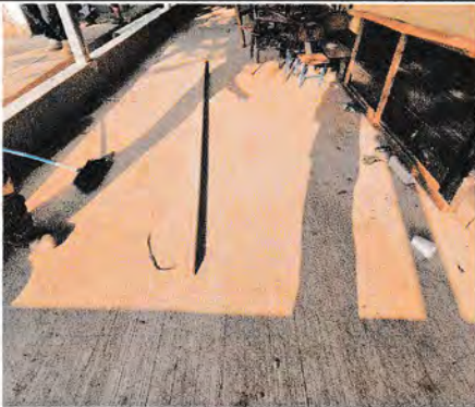
Foto 3: REMOZAMIENTO DE LOSA TERMINADA
