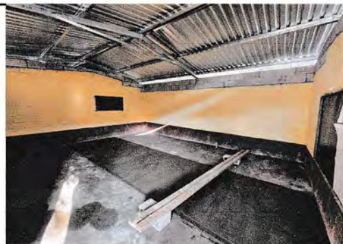
Foto 6: CAMBIO DE LOSA INTERIOR DEL AULA
