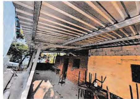
Foto 4: CAMBIO DE LAMINA DEL AULA TERMINADA
