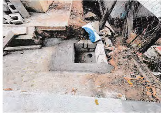
Foto 2: FIN DE CUNETA
