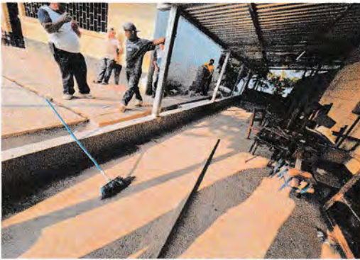
Foto1: REMOZAMIENTO DE CUNETA FINALIZADA
