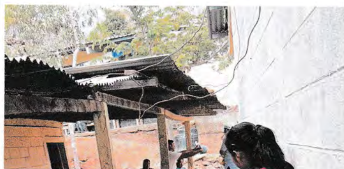
Foto 2: SUMINISTRO E INSTALACIÓN DE LAMINA
