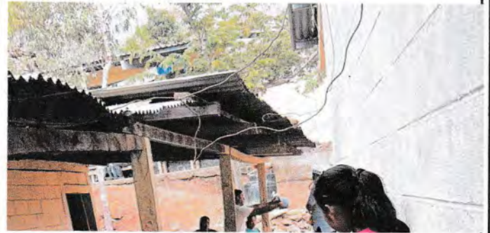
Foto 2: SUMINISTRO E INSTALACIÓN DE LAMINA
