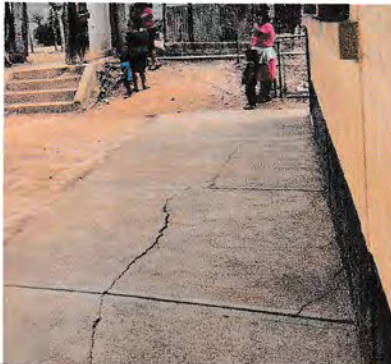
Foto 3: REMOZAMIENTO DE LOSA CONCRETA DEL PATIO EXTERIOR
