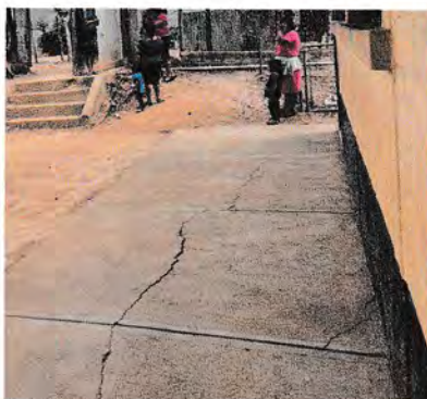
Foto 3: REMOZAMIENTO DE LOSA CONCRETA DEL PATIO EXTERIOR
