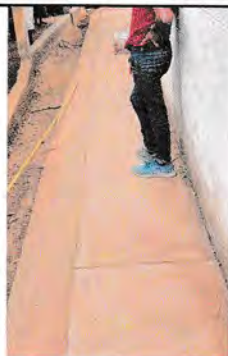
Foto 1: REMOZAMIENTO DE CUNETA EXISTENTE PARA QUE BAJE COMPLETAMENTE EL AGUA
