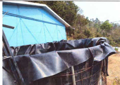
Foto 6: Mantenimiento de deposito de agua.
