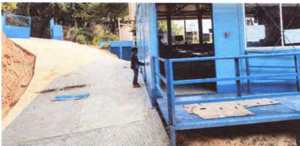
Foto 5: Losa de patio concluida
