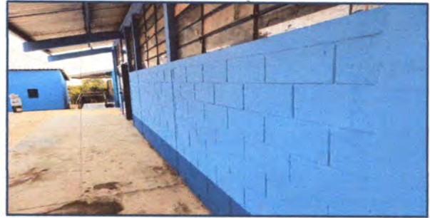
Foto 2: pintura en muros interior y exterior
