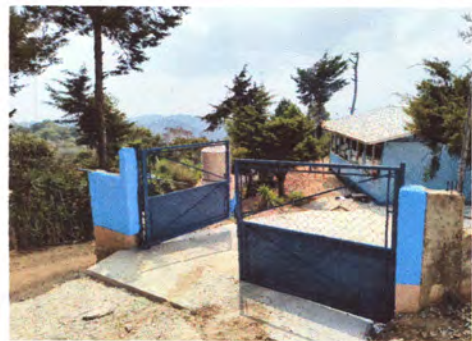
Foto 4: Mantenimiento a porton
