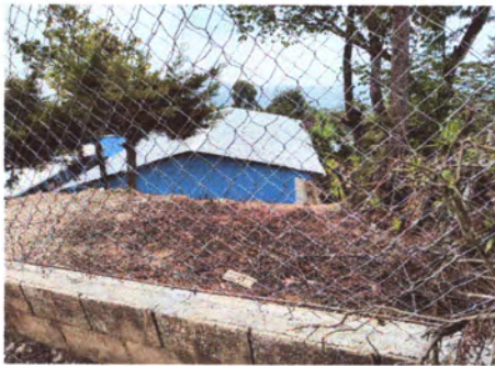
Foto 3: Reparacion de Cerco
