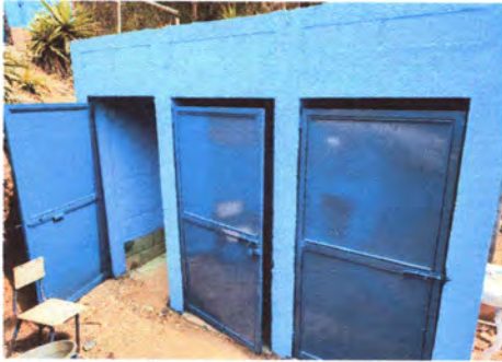
Foto1: Puertas, servicios sanitarios y sus accesorios
