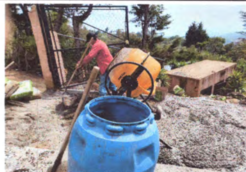
Foto 2: Losa de patio
