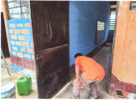
Foto1: Pintura de muros interior y exterior
