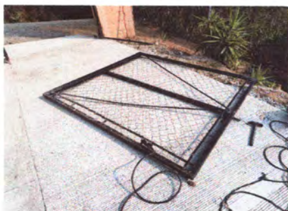
Foto 5: Mantenimiento a porton
