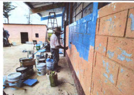
Foto 6: Pintura en muros exterior.
