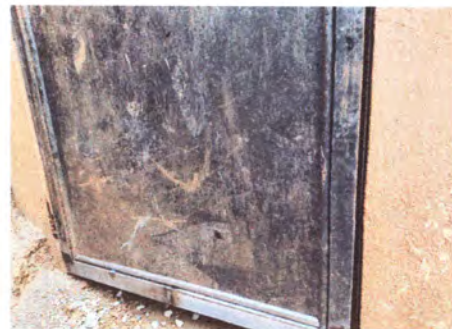
Foto 4: Mantenimiento de puertas
