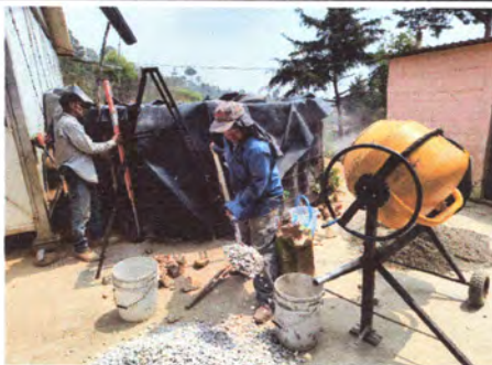
Foto 3: Reparacion y mantenimiento de cisternas/ deposito de agua
