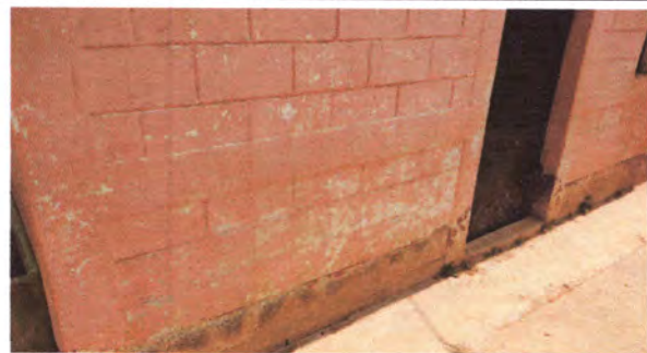
Foto: 6 DETERIORO DE LA PINTURA EN LAS PAREDES DEL ESTABLECIMIENTO
