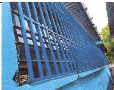
Foto4: Reparación de balcones
