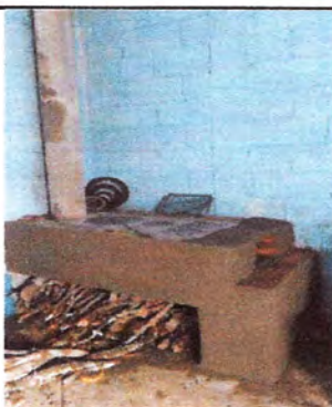
Foto3: Reparación de area de cocina
