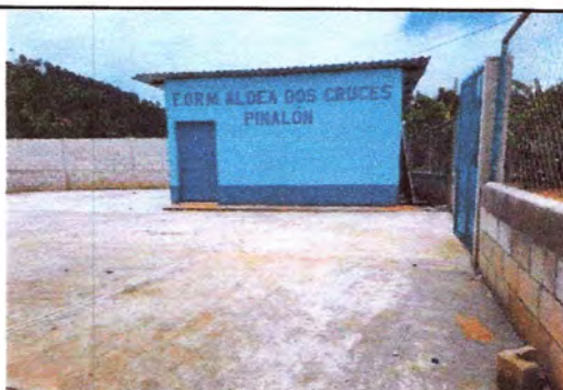
Foto: 6 Pintura de muros y exteriores
