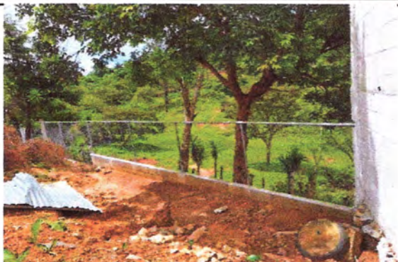
Foto1: Muro perimetral más malla
