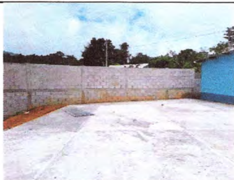
Foto: 5 Losa de patio
