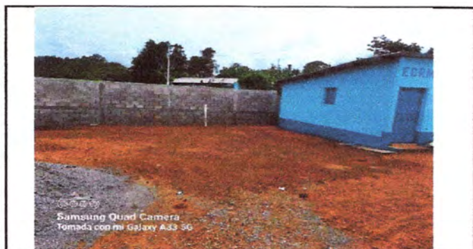
Foto: 5 Losa de patio
