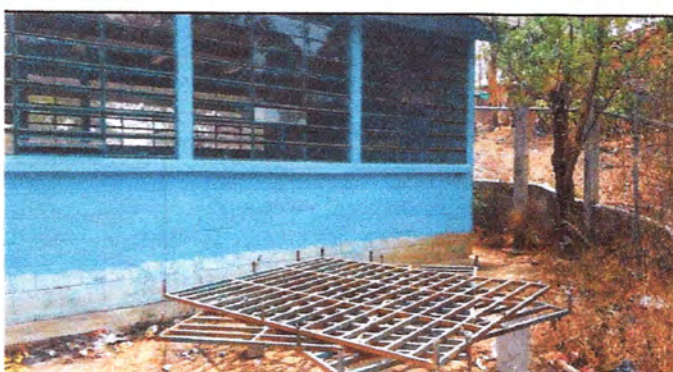
Foto4: Reparación de balcones
