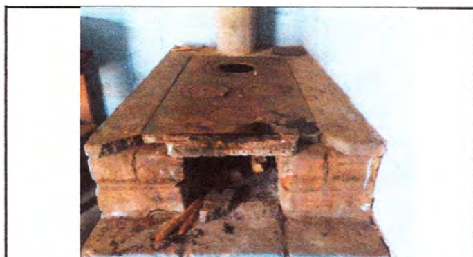
Foto3: Reparación de area de cocina
