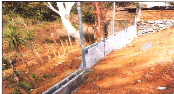
Foto1: Muro perimetral más malla
