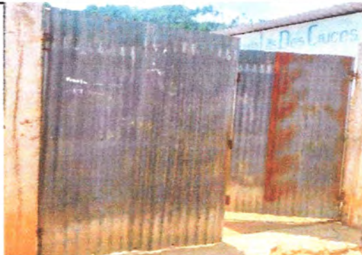
FOTO 2: Mantenimiento de portones
