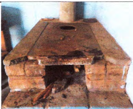
Foto3: Reparación de area de cocina
