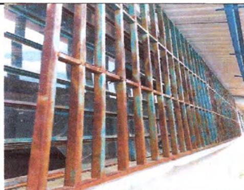
Foto4: Reparación de balcones
