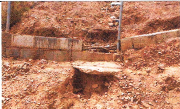
Foto1: Muro perimetral más malla
