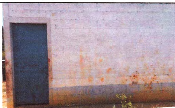
Foto: 6 Pintura de muros y exteriores
