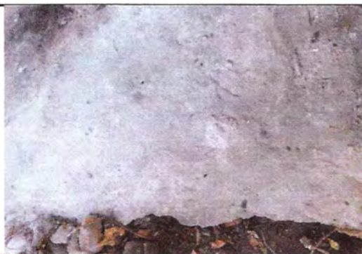
Foto: 5 Losa de patio
