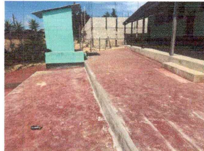
PARTE FRONTAL LOSA PATIO ACABADA
