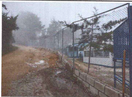
Foto 3: CERCO O MURO PERIMETRAL
