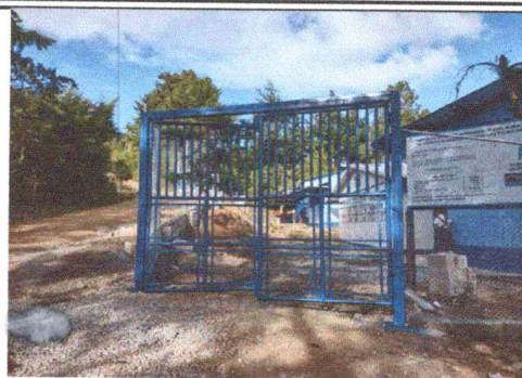
Foto 2: MANTENIMIENTO A PORTÓN
