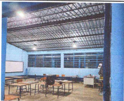
Foto1: REPARACIÓN DE SISTEMA ELECTRICO
