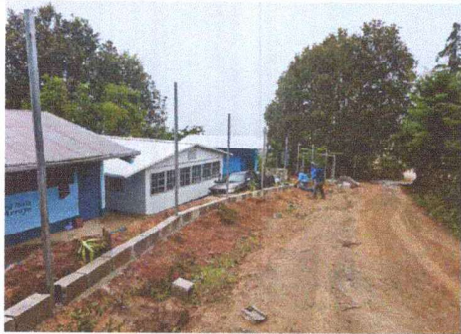
Foto 3: CERCO O MURO PERIMETRAL
