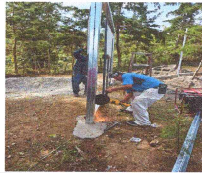
Foto 2: MANTENIMIENTO A PORTÓN
