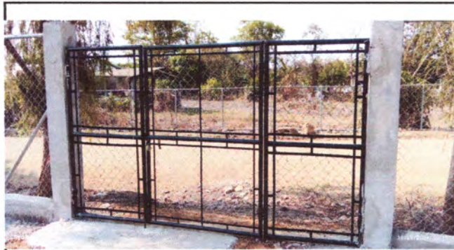
Foto 3: Reparación, ampliación y pintura de porto
