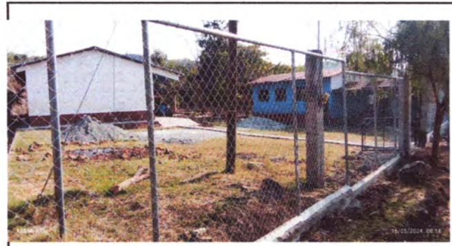
Foto 4: Cambio de Malla en muro
