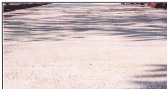
Foto 5: Reparación de losa
