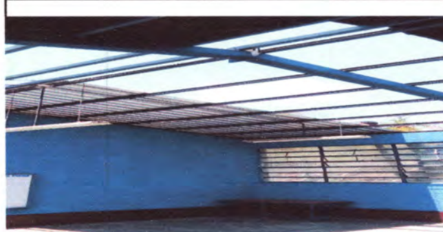
Foto 6: Reparacion de sistema electrico
