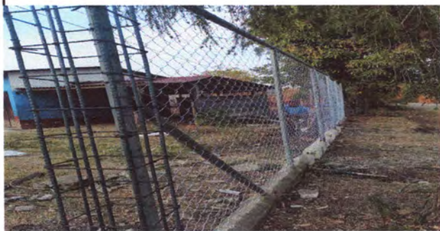
Foto 3: Reparacion y Ampliacion y pintura de porton
