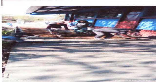
Foto 5: Reparacion de losa
