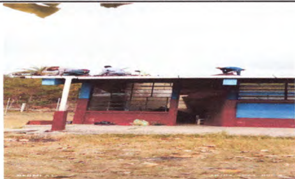
Foto1: Reemplazo de Lamina
