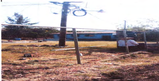
Foto 4: Cambio de malla en muro
