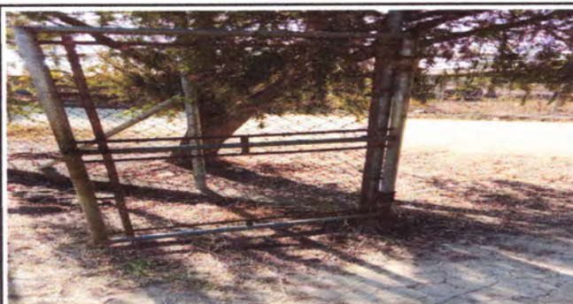
Foto3: REPARACION, AMPLIACION Y PINTURA DE PORTON
