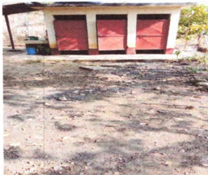
FOTO 2: CONSTRUCCION DE FOSA SEPTICA
