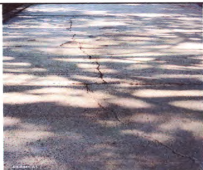
Foto: 5 REPARACION DE LOSA
