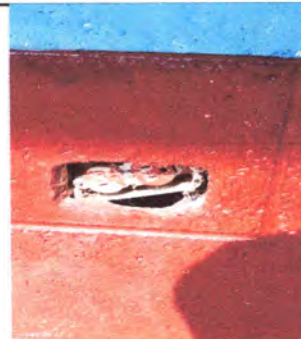
Foto: 6 REPARACION DE SISTEMA ELECTRICO
