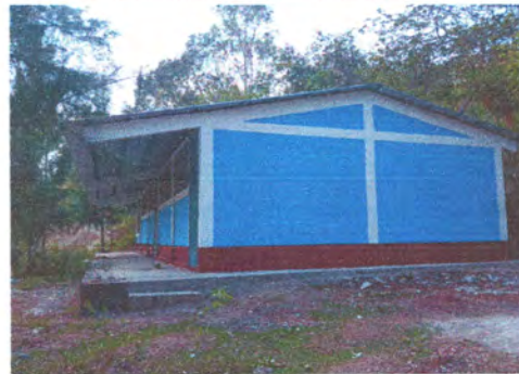
Foto 6: Finalización de trabajo en la escuela.
