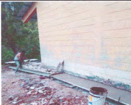
Foto 3: Fundición de banqueta
