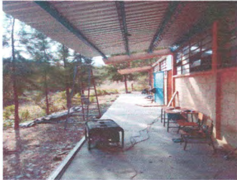
Foto1: Desmontaje de canaleta
