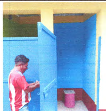
Foto 4: Verificación de puertas reparadas
